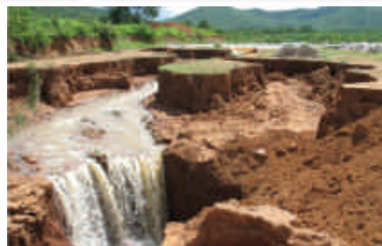
Figura 38 - Solos com sinais de erosão
